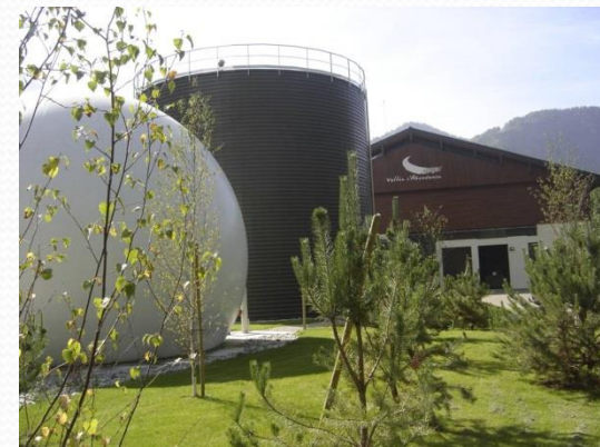
Station d'épuration d'Abondance (source: ancienne 2CVA)
