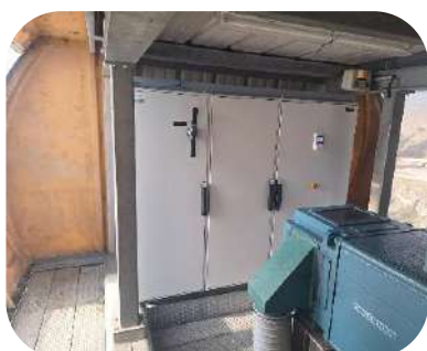
Changement de l'armoire de puissance
