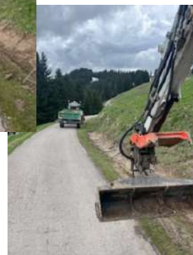
Réalisation de travaux de curage de fossés en régie
