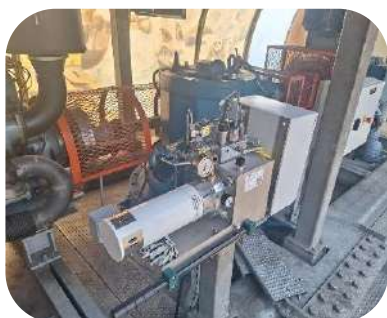
Remplacement de la centrale de frein n°2
