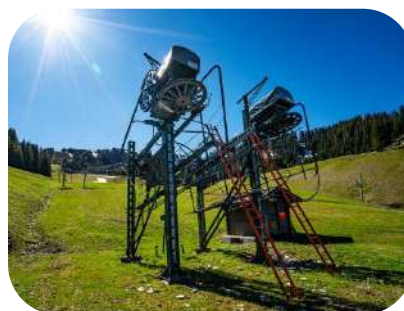
Contrôle complet et entretien poussé des autres installations remontées mécaniques (Téléskis)
