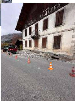
Travaux de sécurisation et mise en conformité de trottoir au droit de l'ancienne colonie La Fougère des Alpes
