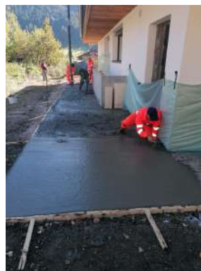
Aménagement de trottoir Personnes à Mobilité Réduite (PMR) au cabinet médical avec une sortie pour le cabinet d'Orthophonie
